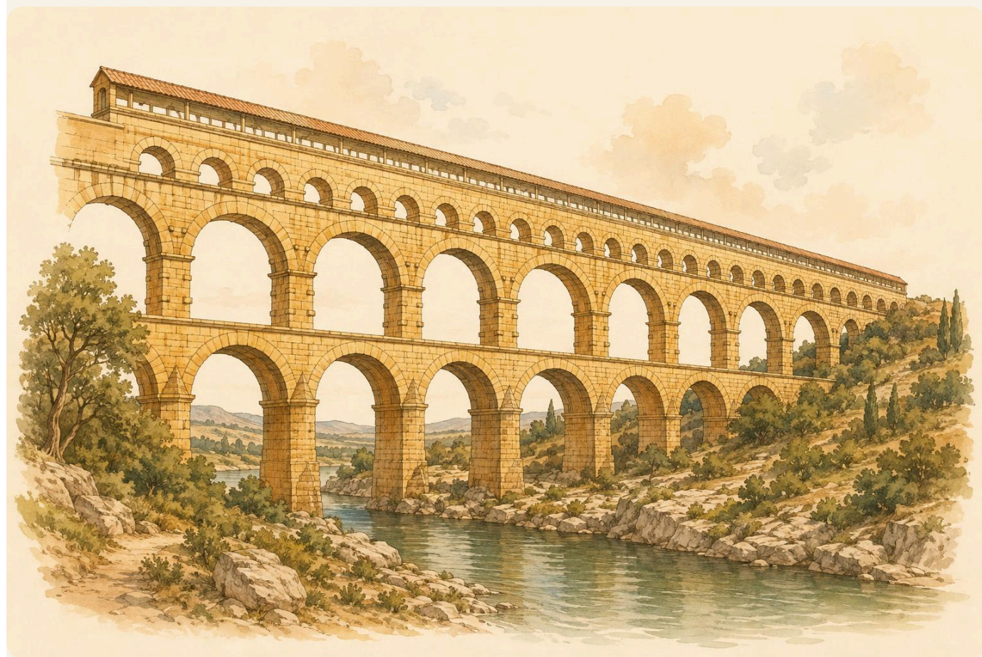
加尔桥（示意）：三层叠拱跨过河谷，桥顶那条不起眼的水渠才是整座桥的主角。
