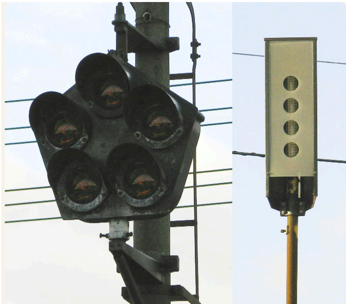
特殊信号発光機の種類：左は回転型、右は点滅（閃光）型。边坡落石切断感应線の瞬間、它们不经任何上级系统直接亮红。图：Ncsa3809 / CC BY-SA 3.0 / Wikimedia Commons
