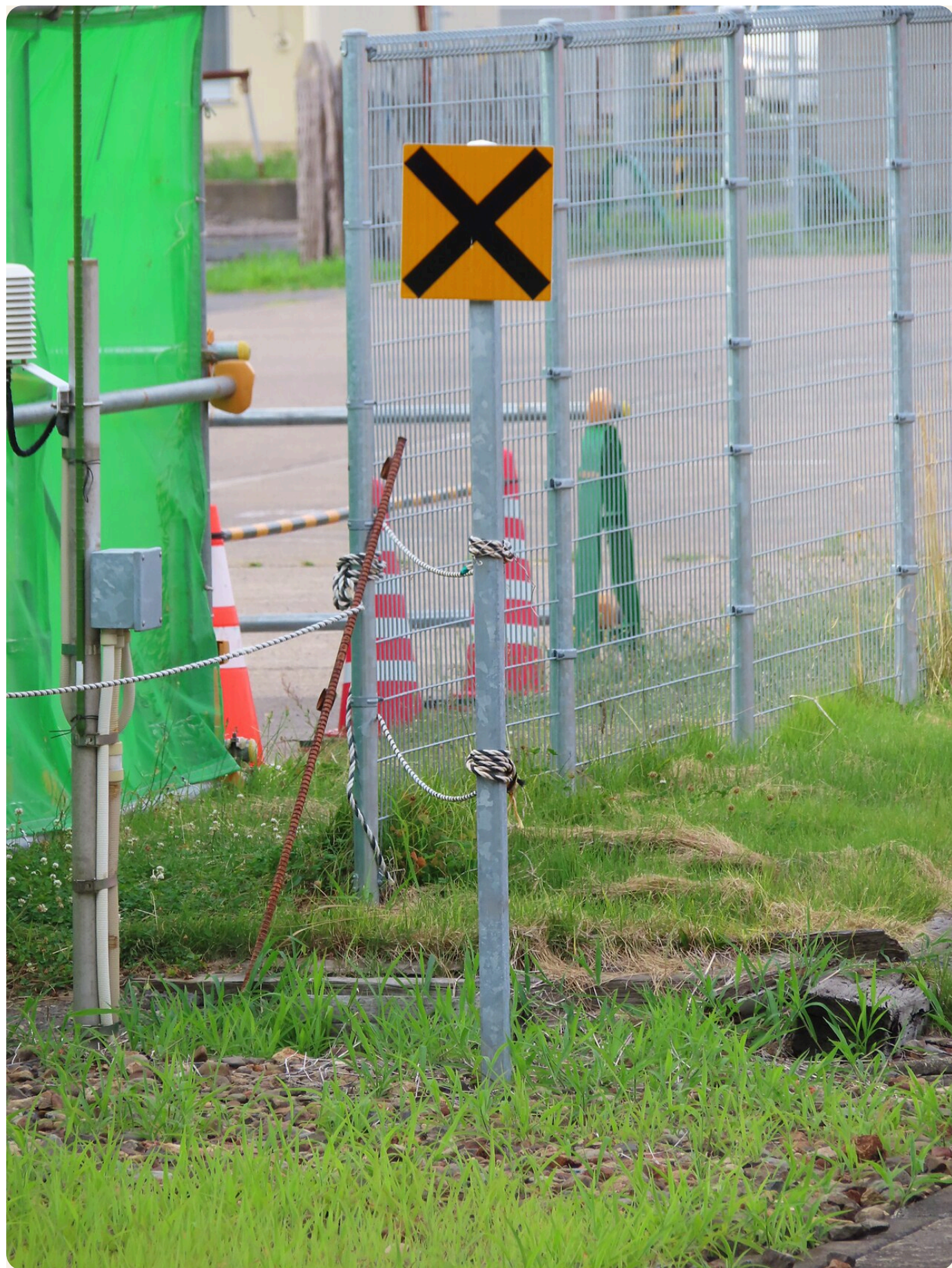
鸣笛标的另一种长相：黄底黑叉（五能线五所川原站）。它立在这里是因为前方有一处第 4 种道口——没有遮断杆、没有警报机，汽笛就是那个道口全部的防护。图：運動会プロテインパワー / CC BY-SA 4.0 / Wikimedia Commons
