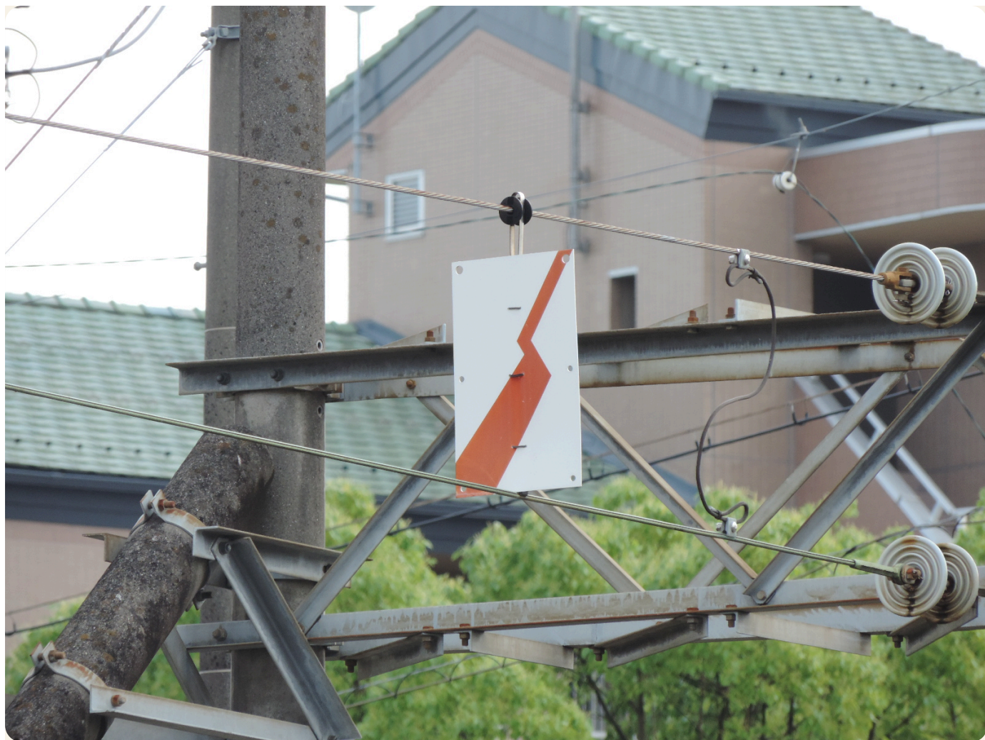
架線終端標識实物（名鉄犬山站）：白底红闪电——电气化王国的国境告示，电车越过此牌就是搁浅。图：運動会プロテインパワー / CC BY-SA 4.0 / Wikimedia Commons
