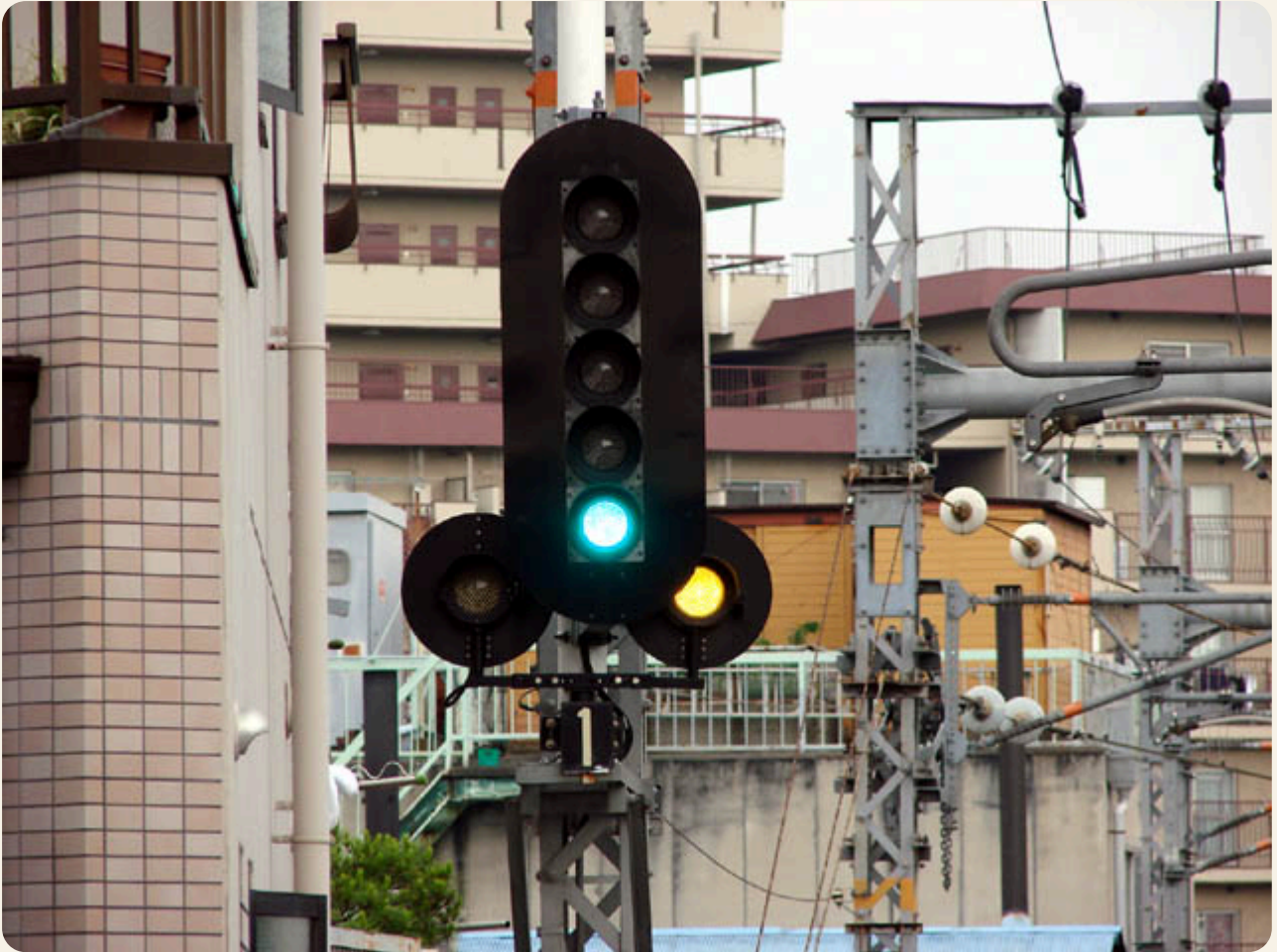
区间里的闭塞信号机，正亮着绿灯（進行）。下方两侧的辅助灯是进路预告显示，柱子上的「1」是它的编号牌（大阪环状线区间）。图：w0746203 / CC BY 2.5 / Wikimedia Commons
